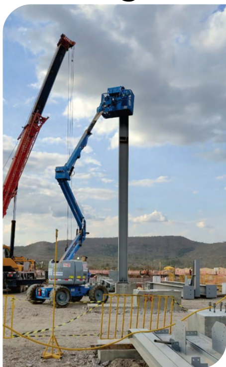
1º pilar da estrutura do prédio de filtragem
